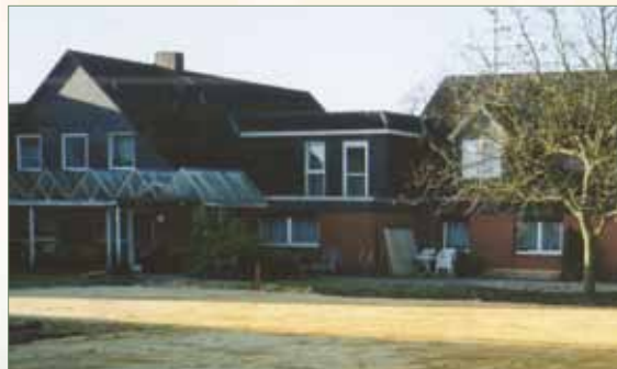
Hausansicht vor dem Umbau
