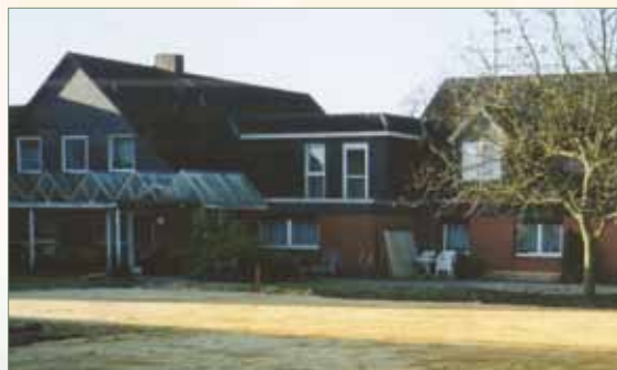
Hausansicht vor dem Umbau
