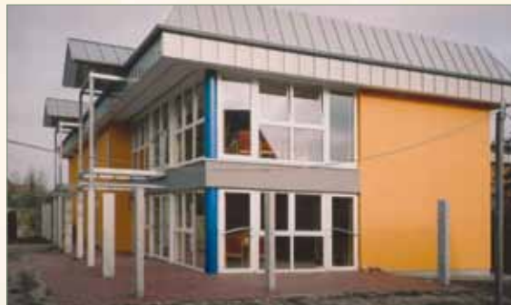
Hausansicht nach dem Umbau
