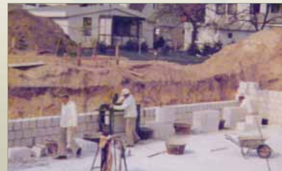
Das Fundament nimmt Form an
