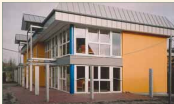
Hausansicht nach dem Umbau
