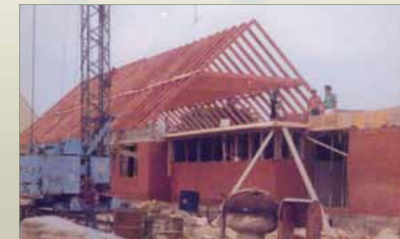
Das Dach entsteht
